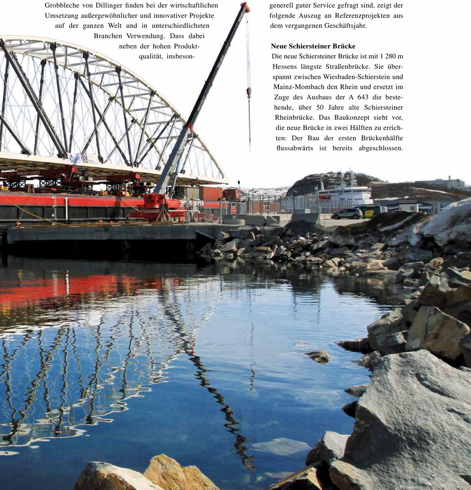
Seit November 2017 wird der Verkehr auf diesen Brückenteil geführt, so dass die bestehende Brücke flussaufwärts nun abgerissen und neu gebaut werden kann. Nach Abschluss der Baumaßnahme wird eine dreispurige Verkehrsführung mit Standstreifen je Fahrtrichtung auf den beiden getrennten neuen Bauwerken zur Verfügung stehen. Dillinger lieferte für den Überbau der ersten Brücke 6 880 Tonnen Grobblech.
